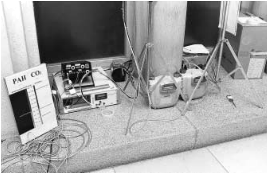
Mit diesen hochempfindlichen Messeinrichtungen werden in den nächsten Monaten innerhalb der kantonalen Verwaltung Räume von unterschiedlichstem (Nutzungs-)Charakter auf ihre Innenraumluft-Qualität hin untersucht.
