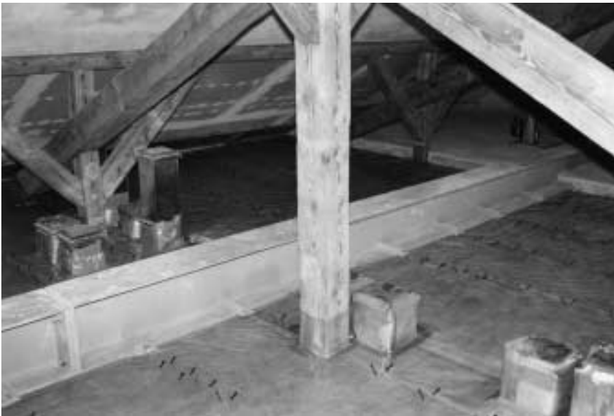
Abb. 4: Wärmeisolation des Daches mit Zelluloseflocken, statische Verstärkung mit Stahlträger und Verbundbeton (Nägel im Boden für Verbund) zur Aufnahme der Lüftungszentrale
