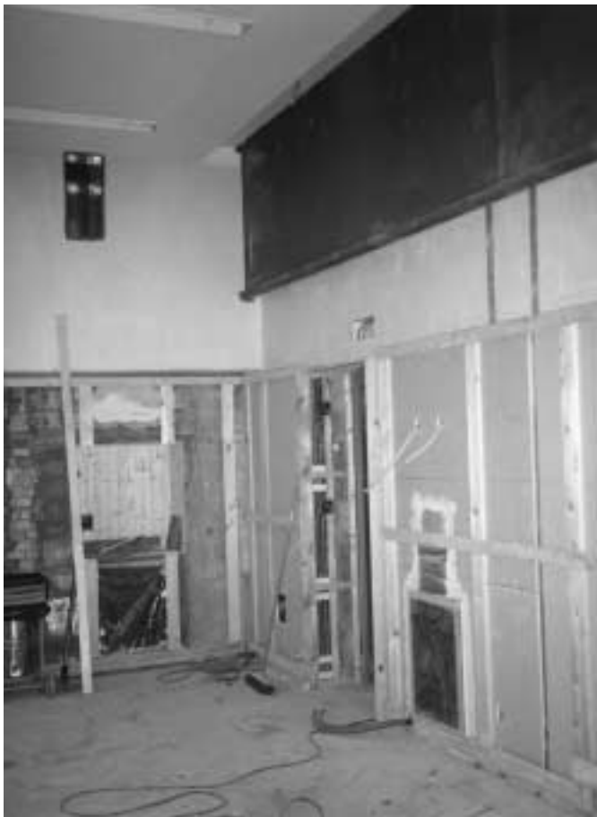
Abb. 2: Installationsschächte in Gebäudenischen (Backsteinmauer links), Aufputzinstallationen (bestehender Verputz wurde belassen), statische Verstärkung in Stahl unverkleidet (oben).
