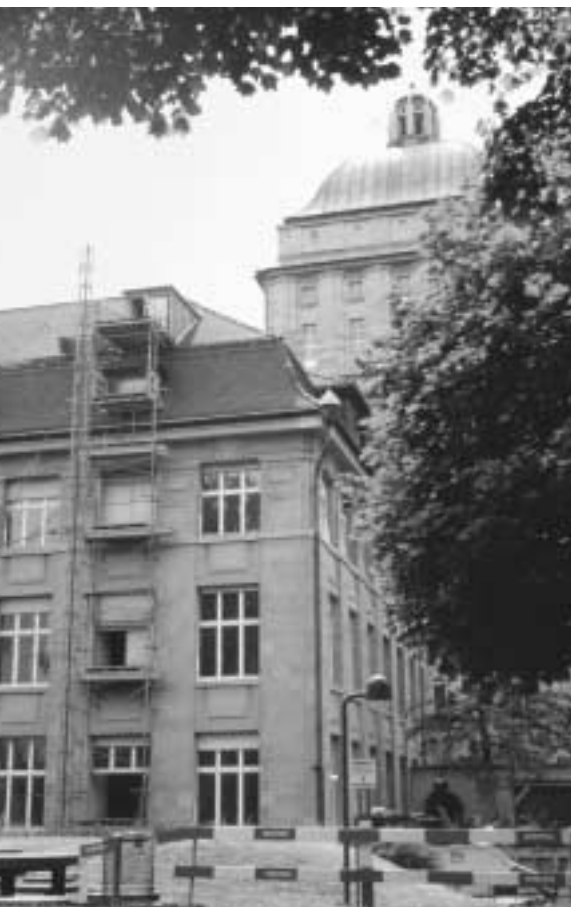
Abb. 1: Universität Zürich, Kollegiengebäude I, Ansicht der ersten Baustufe der Gesamtsanierung.
