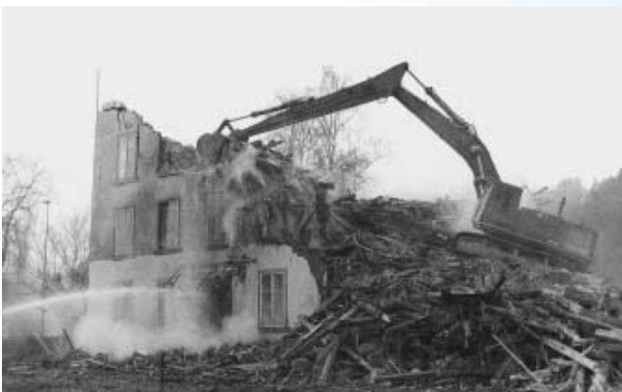
Der Abbruch-, Aushub- und Recycling-Verband Schweiz (ARV) ist einer der drei Verbände, die mit dem Kanton Zürich eine Vereinbarung zum Vollzug des Umwelt- und Gewässerschutz-Rechts unterzeichnet haben. Bild: ARV
