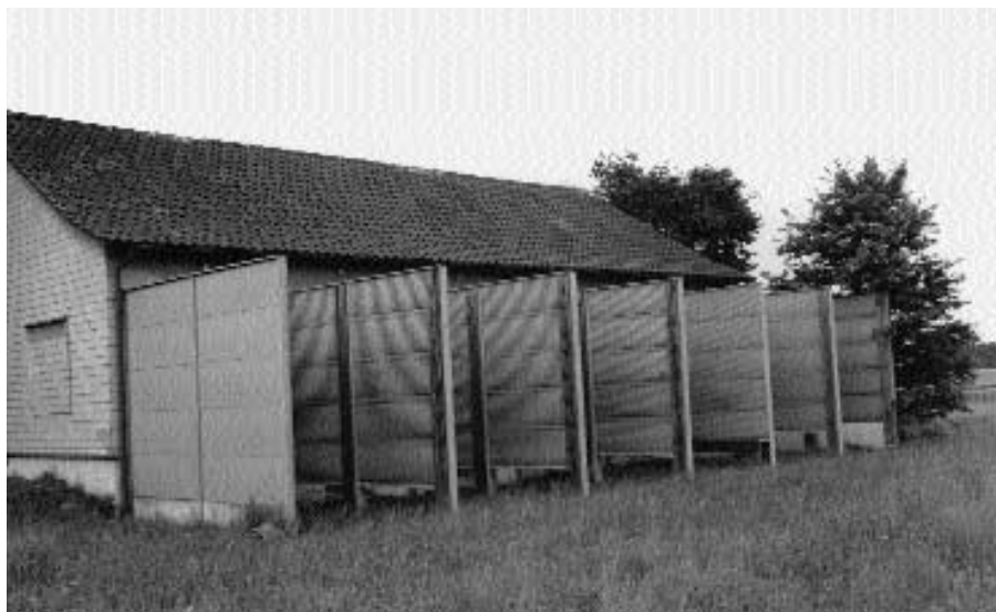
Abb. 4: Seitenblenden zur Reduktion des Mündungsknalls
