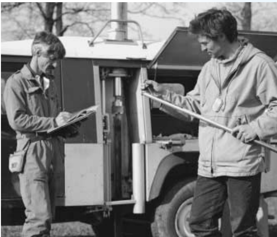
Kartierer mit Bohrfahrzeug zur Entnahme von Bodenproben
