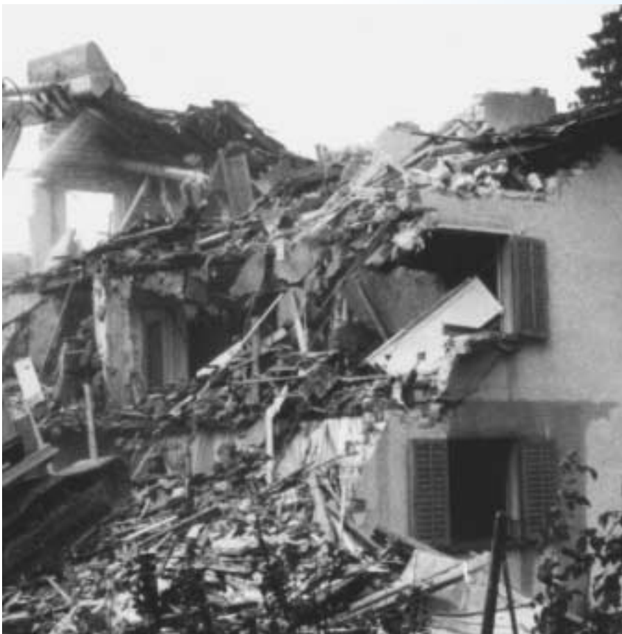
Geordneter Rückbau statt unkontrolliertem Abbruch: Zusammen mit der strikten Trennung nach Fraktionen wird so die Wiederverwertung eines Grossteils der mineralischen Bauabfälle ermöglicht. Foto: AWEL, Abfallwirtschaft und Betriebe
