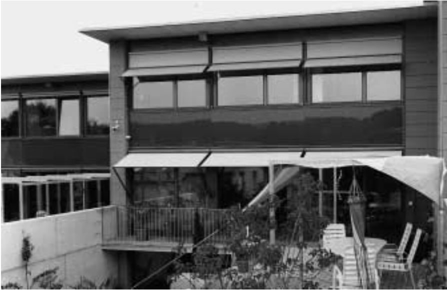
Eine ganze Einfamilienhaussiedlung («Am Krebsbach» in Winterthur-Oberseen) wurde mit dem MINERGIE-Label ausgezeichnet.
