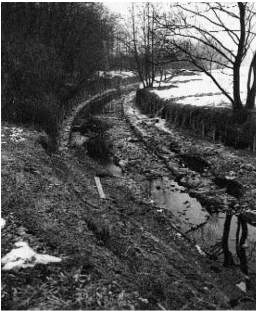
Ein seltenes Bild, das auch die durch die Jahrzehnte gewachsene Verschmelzung von Natur und technischen Eingriffen veranschaulicht: Der Oberwasserkanal im entleerten Zustand während der Überholung der Turbinenanlage um 1981.
