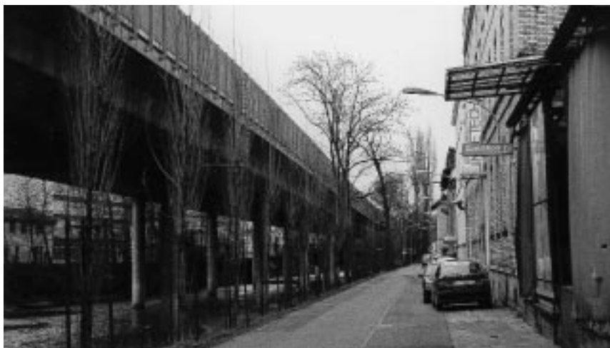
Sihlhochstrasse, Abschnitt mit drei Meter hohen Lärmschutzwänden. Brücke und Lärmschutz wirken beliebig.
