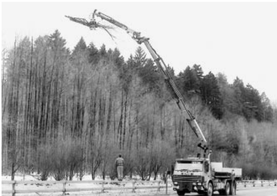
«Holzrücken» auf Flächen, die nur von der Autobahn her zugänglich sind. Die Sonne muss ungehindert auf die Fahrbahn scheinen können, damit sich im Winter weniger Glatteis bilden kann. Bild: Tiefbauamt Kanton Zürich
