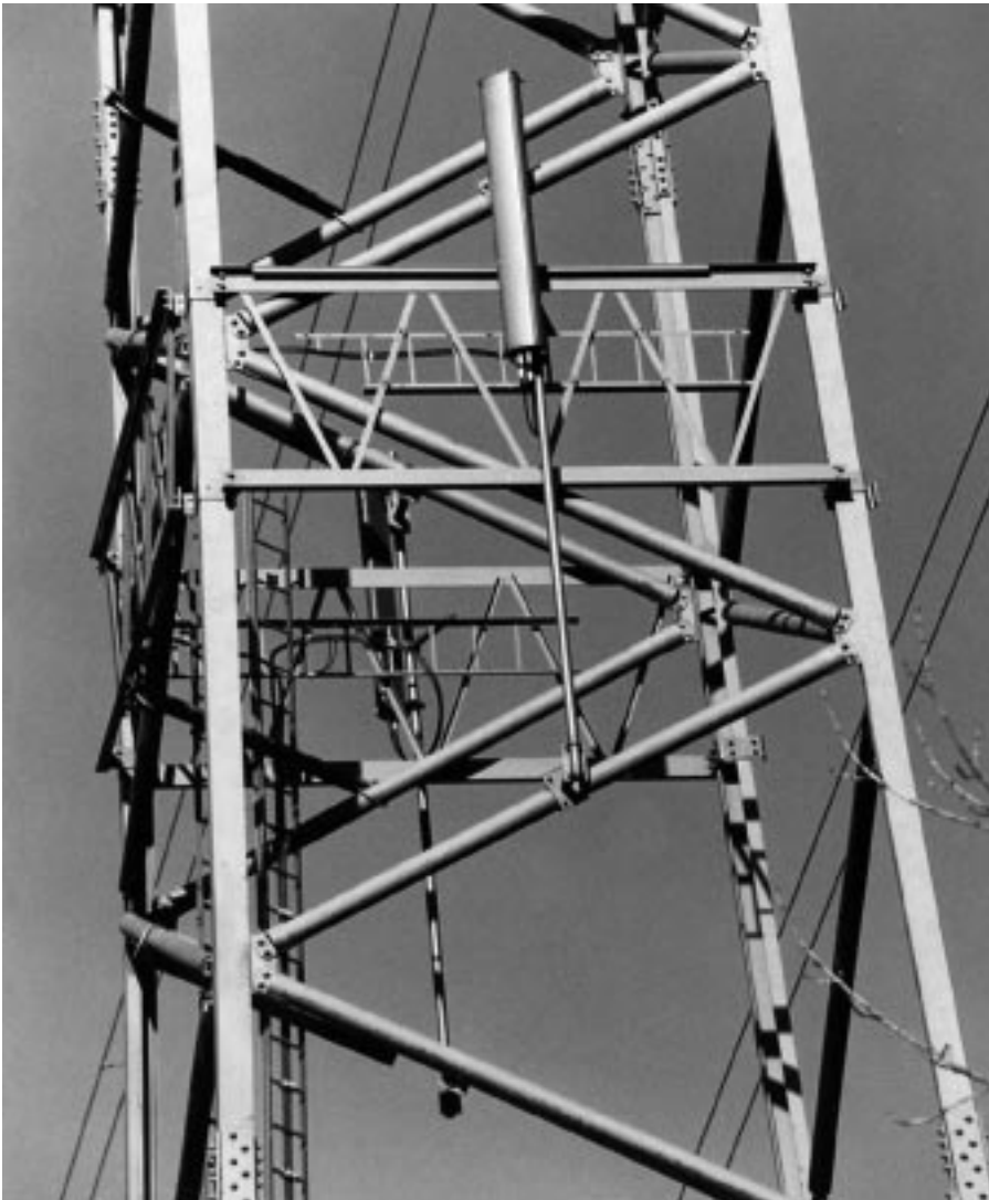
Mobilfunkantennen können auch an Orten angebracht werden, wo bereits Freihaltebereiche bestehen, zum Beispiel wenn sie mit einer Hochspannungsleitung kombiniert werden.
