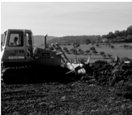
Nach einer Auffüllung wird das Gelände mit einer Moorraupe humusiert.
