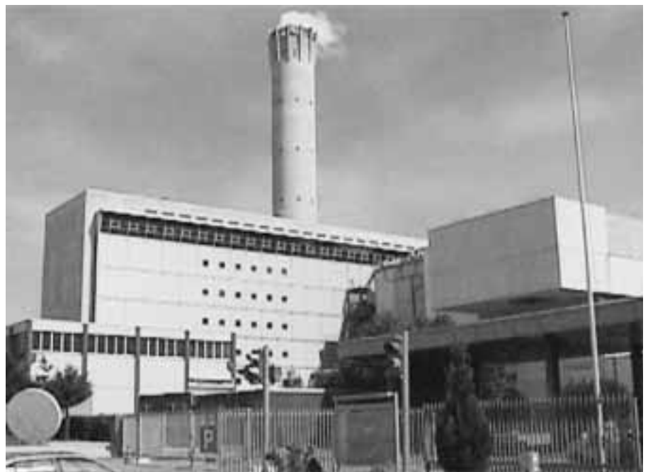
Dank Rauchgasreinigungsanlagen emittieren Kehrrechtverbrennungsanlagen nur noch geringe Säuremengen. Im Bild: KVA Hagenholz
