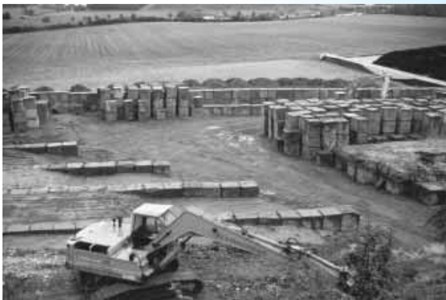
In Zementblöcken verfestigter Abfall (so genannte Reststoffe) wird zur Ablagerung in der Deponie Winterthur aufgeschichtet.
