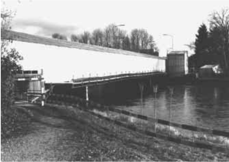
Vorbildliche Einhausung einer Strassenbrücke bei Schlieren.
