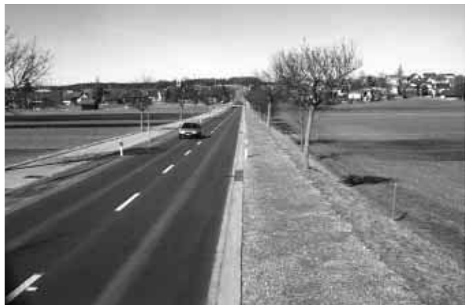
...und nach dem Bau der Nationalstrasse 4.
