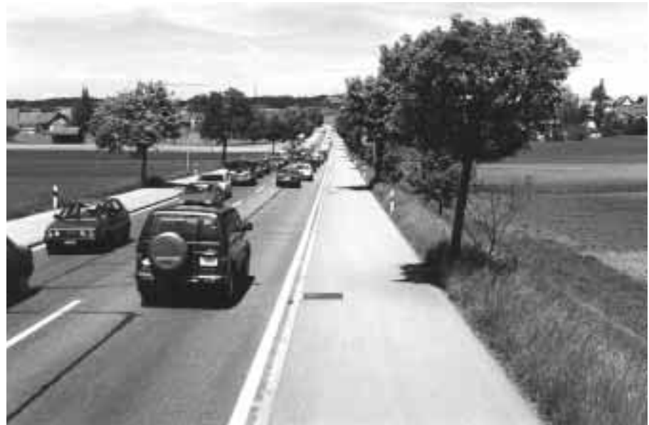
Zufahrt zum Dorf Hettlingen: Vor dem Bau der Nationalstrasse 4...
