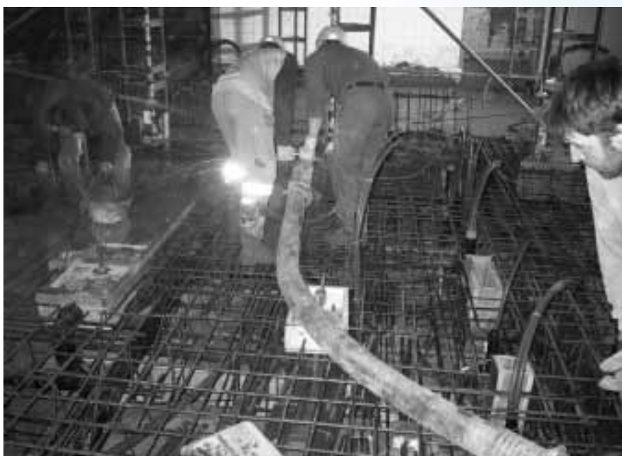
Einsatz von Recyclingbeton beim Umbau der Mensa der Universität Zürich.
