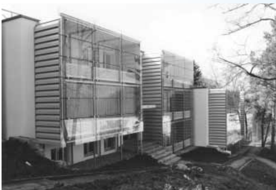
Ein Glasschild vor der Fassade und schalldämpfende Lamellen machen am Marktweg in Gattikon eine massive Lärmreduktion möglich.
