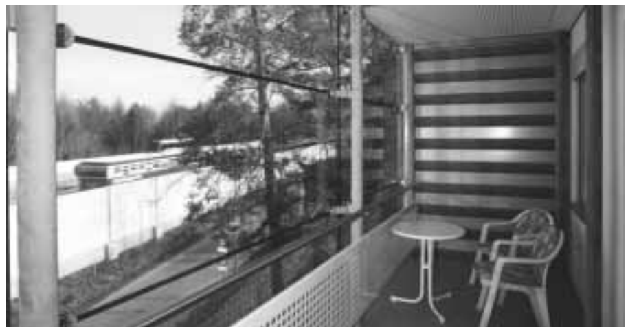
Ohne Glasschild wäre eine doppelt so hohe Lärmschutzwand nötig gewesen.
