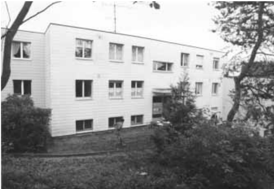
Die Überbauung Marktweg vor der Sanierung: Die Wohnungen waren dem Autobahnlärm ungeschützt ausgesetzt.
