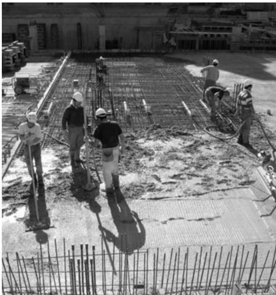
Der Neubau Technische Berufsschule Zürich ist nach MINERGIE zertifiziert. In die Submissionsunterlagen werden Leistungsbeschreibungen mit ökologisch relevanten Ausführungen aufgenommen. Wo es sinnvoll ist, wird – wie im Bild am Guss einer Decke zu sehen ist – Recyclingbeton eingesetzt. (Projekt: Stücheli Architekten, Projektleitung HBA)
