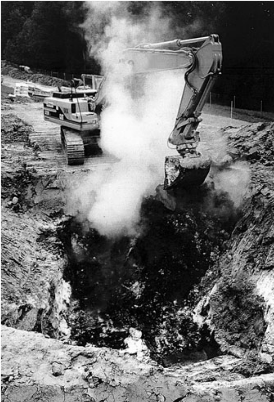
Die Entsorgung kann dramatisch aussehen: Öffnung einer Deponie und Entfernen des kontaminierten Materials. Ein Wasservorhang soll das Entweichen giftiger Gase reduzieren.
