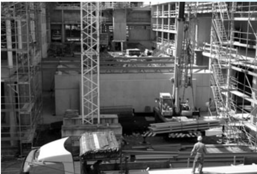
Die Belastung mit Feinstaub (PM10) liegt in weiten Teilen des Kantons über den zulässigen Grenzwerten. Eine wesentliche Ursache ist der Schadstoffausstoss auf Baustellen. Quelle: AWEL/LH
