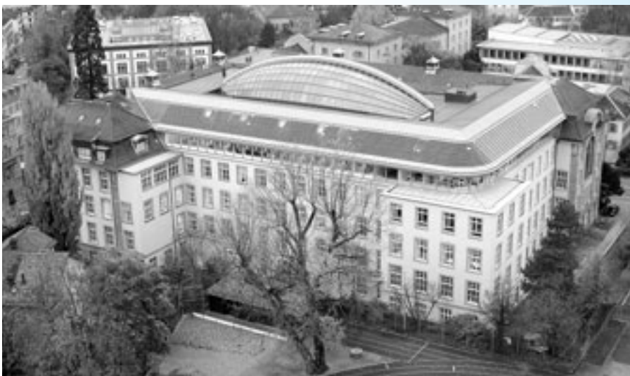
Das Kupferdach der Rechtswissenschaftlichen Fakultät der Universität Zürich fügt sich harmonisch in die bestehende Überbauung ein.
