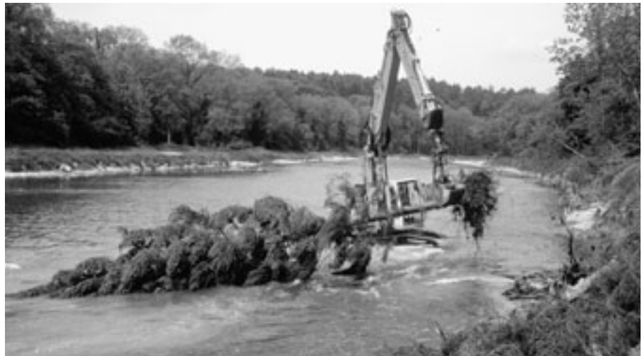
Zur Ufersicherung wurden Baumstämme und Blocksteine eingebaut.
