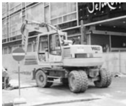
Baumaschinen mit Partikelfilter reduzieren die PM_{10} -Belastung.
