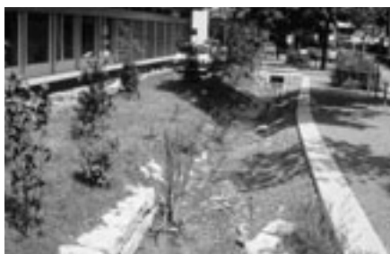
Der offen gelegte Döltschibach in Zürich Albisrieden in seinem neuen naturnahen Gerinne zwischen Strasse und Gebäude (August 1995).
