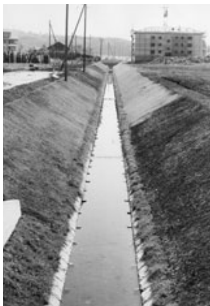
Grendelbach Effretikon: Ein «ordentlich» ausgebauter Bach.
