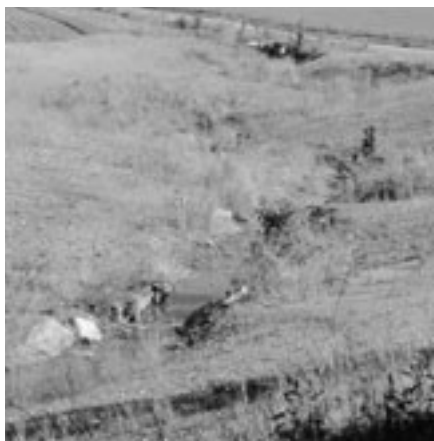
Der neu offen geführte Sulzergraben in der Gemeinde Rickenbach.
