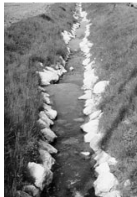
Waltensteiner Eulach: Von Adolf Huber und seiner Unterhaltsequipe anfangs der Siebzigerjahre «unordentlich» ausgebauter Bach.
