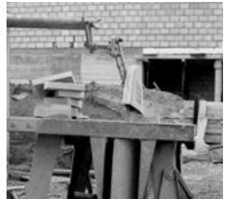
Wird ein Gerät abgeschirmt aufgestellt – im Bild eine Trennscheibe – vermindert dies deutlich die Lärmimmission.
