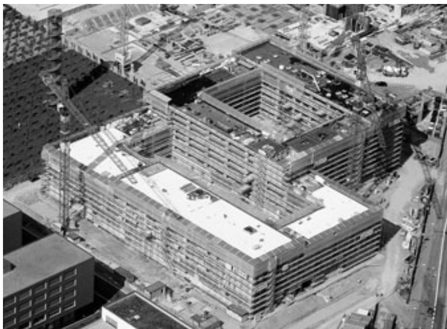
Objekt Max Bill in Oerlikon. Sämtliche Betonarbeiten wurden mit RC-Beton (20 000 m 3 ) ausgeführt. Quelle: Eberhard Bau AG
