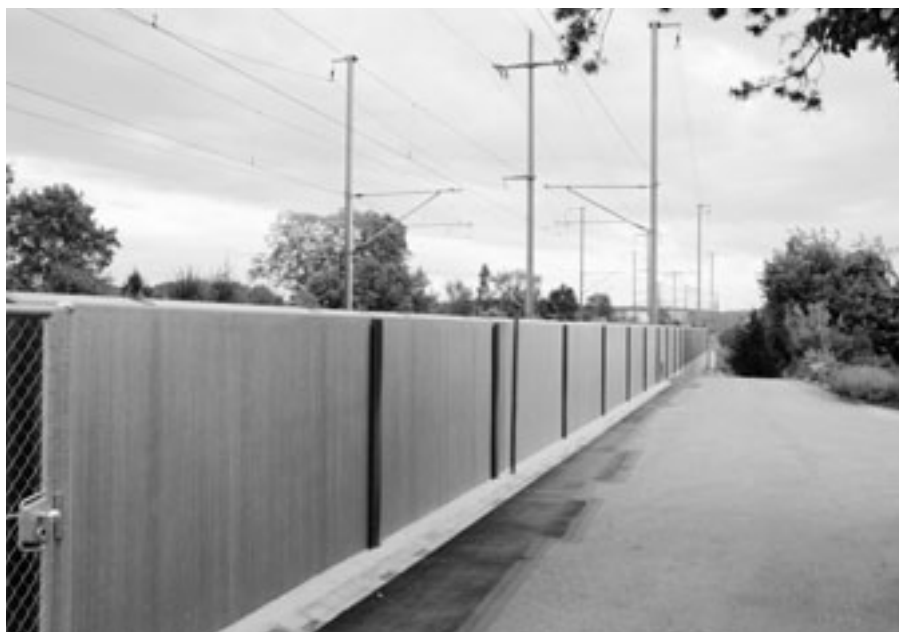
Die Lärmschutzwände der SBB passen sich in ihrer Einheitlichkeit gut an die bestehenden linearen Bahnstrukturen an. Einheitlichkeit kann aber – eng interpretiert – auch Widerstand verursachen. (Bild: Niederglatt, SBB-Beton-Lärmschutzwand, glatte Oberfläche mit «Besenstrich»-Relief.)
