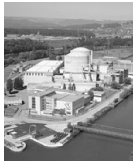
Die Kraftwerke Beznau I und II der NOK wurden bereits 1969 und 1971 gebaut. Die Zeit, in der sie noch Energie produzieren können, ist damit absehbar. Quelle: NOK
