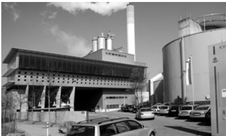
Klärschlamm aus Abwasserreinigungsanlagen wird heute verbrannt und darf nicht mehr auf die Felder ausgebracht werden. Zur Zeit wird Klärschlamm zum grössten Teil nach einer mechanischen Entwässerung in speziellen Klärschlammverbrennungsanlagen oder in KVAs verbrannt.
