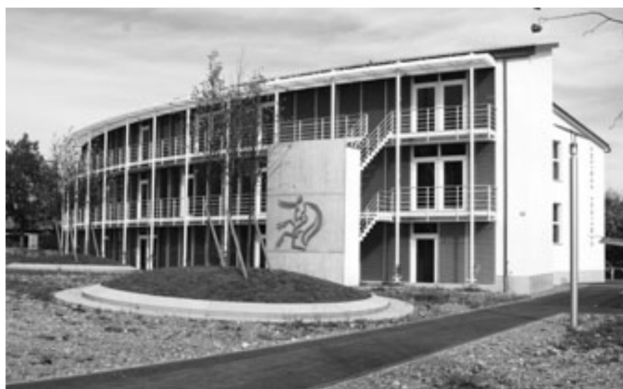
Die nach Minergie-Standard gebaute Gemeindeverwaltung Rümlang.
