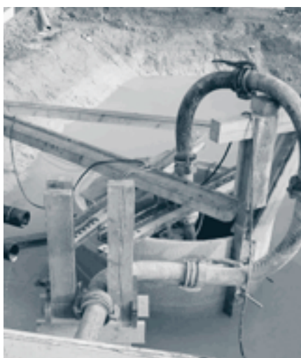
Weiss ein Bauarbeiter, wohin er das eventuell alkalische Baugrubenabwasser abpumpt? Ein Absetzbecken, wie rechts im Bild, befreit das Abwasser von Feststoffen, so dass es – wo nötig nach einer Neutralisation – in die Schmutz- oder Mischwasserkanalisation abgeleitet werden darf.
