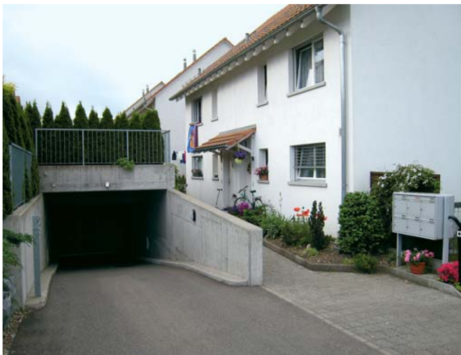
Tiefgaragenrampen werden zum Lärmproblem, wenn sie unmittelbar neben lärmempfindlichen Räumen ins Freie führen. Quelle: TBA
