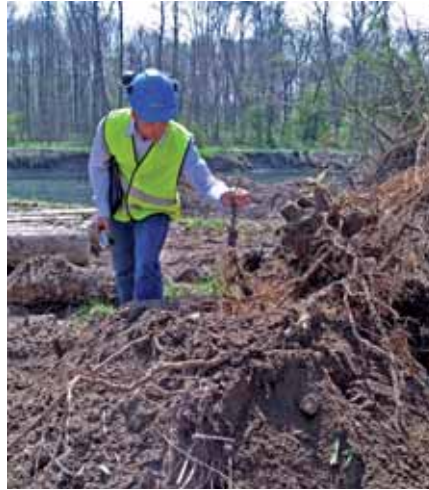
Japanknöterichbestand unterhalb Andelfingen (links). Aushub betroffener Flächen muss auf Rhizome des Japanknöterichs untersucht werden (rechts).
