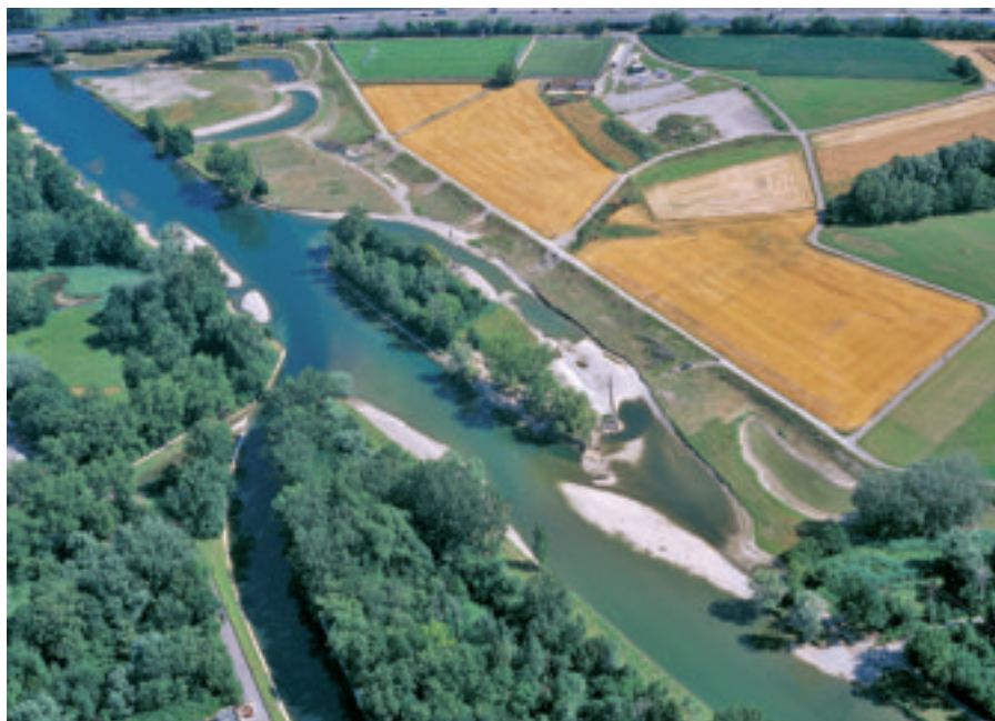
Überblick über den renaturierten Abschnitt der Limmat mit den aufgeschütteten Kiesbänken. Auf Geroldswiler Seite trennt ein Zaun diese vom begehbaren Weg ab, auf der Dietiker Seite gibt es eine Strecke mit freiem Zugang.
