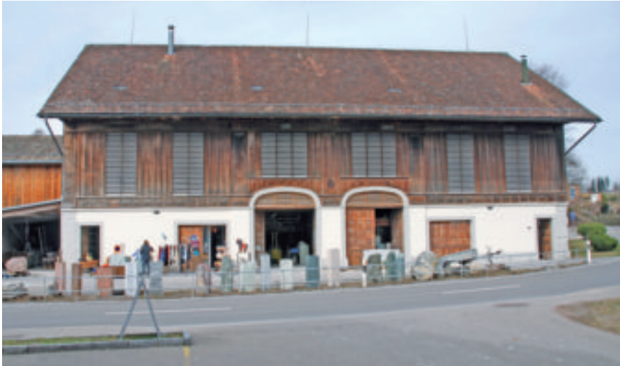
Nicht jedes Gebäude eignet sich zum Wohnen. Nach der Erwägung verschiedener Nutzungskonzepte wurde diese Scheune nach denkmalpflegerischen Grundsätzen restauriert und dient heute gewerblichen Zwecken.
