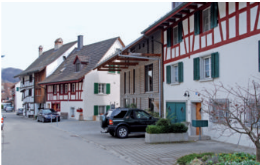
Als geschlossene Holzfassade zwischen den benachbarten Riegelbauten behauptet sich dieser Ersatzneubau in Egglisau unaufdringlich. Die Struktur von gemauertem Stall und der darüber liegenden Scheune in Holzkonstruktion wurde fallen gelassen, weil das Haus nicht mehr horizontal genutzt wird.
