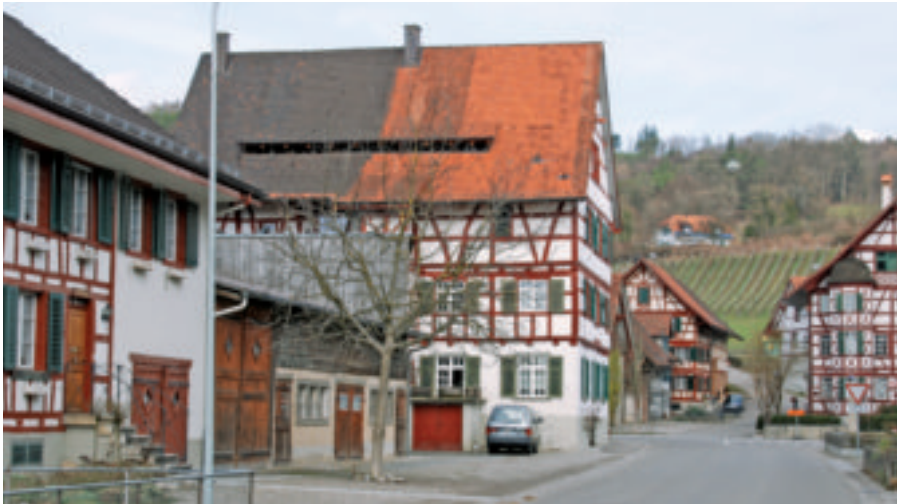
Statt einer gängigen Giebellukarne wurde hier in Oberstammheim eine individuelle Lösung mit Dachabsatz gewählt, die wie eine traditionelle Belüftungsgaube wirkt.
