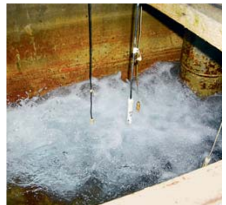
Die Online-Gewässerüberwachung in den Absetzbecken ermöglichte, jede Belastung des Grundwassers frühzeitig festzustellen.
