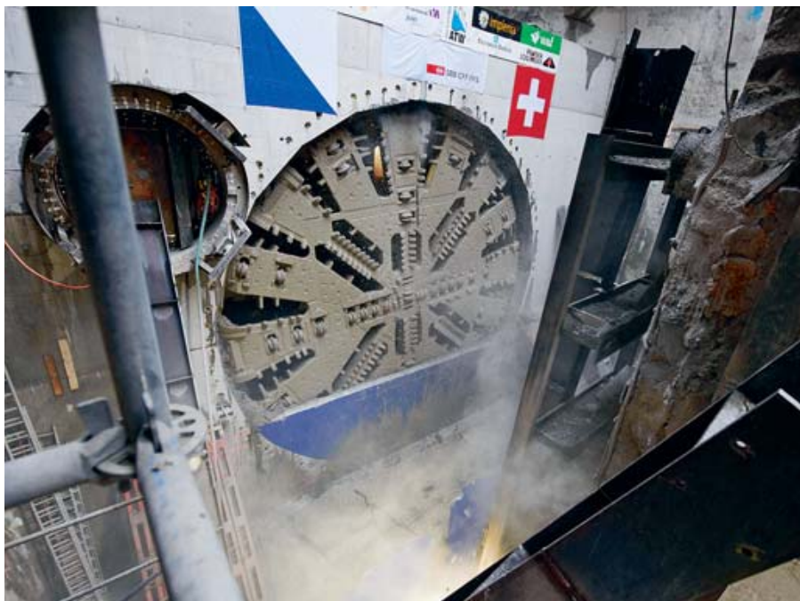
Beim Bau der Durchmesserlinie handelt es sich mitten in der Stadt um ein enormes, komplexes Vorhaben. Im Bild: Durchschlag der Tunnelbohrmaschine im Schacht Südtrakt.
