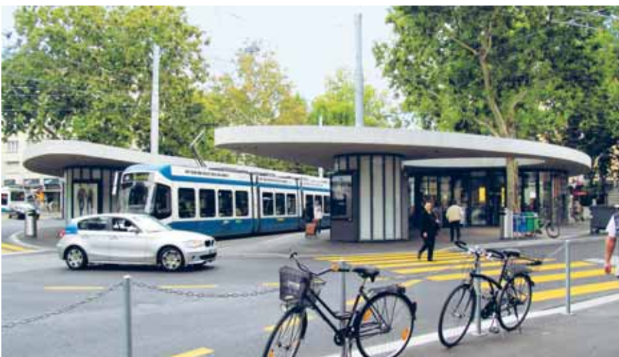
Kreisrunde Zylinder am Limmatplatz Zürich streuen den tieffrequenten Schall und mindern die Unruhe des Platzes.
