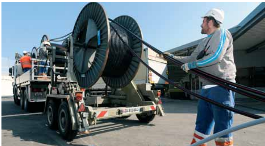
Das Verlegen von Energiekabeln ist eine von vielen Aufgaben der Netzbetreiber.
