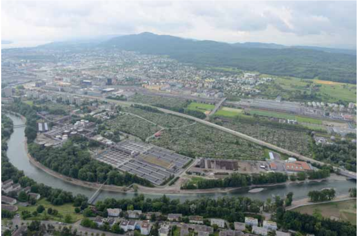
Im Projekt «Limmatauen Werdhölzli» in der Stadt Zürich wurde nicht nur der Hochwasserschutz zwischen dem Stauwehr Zürich-Höngg und der Autobahnbrücke bei Oberengstringen verbessert. Gleichzeitig wurde der 1,8 Kilometer lange Limmatabschnitt aufgewertet und damit auch mehr Raum für Artenvielfalt und Erholungsqualität geschaffen.
