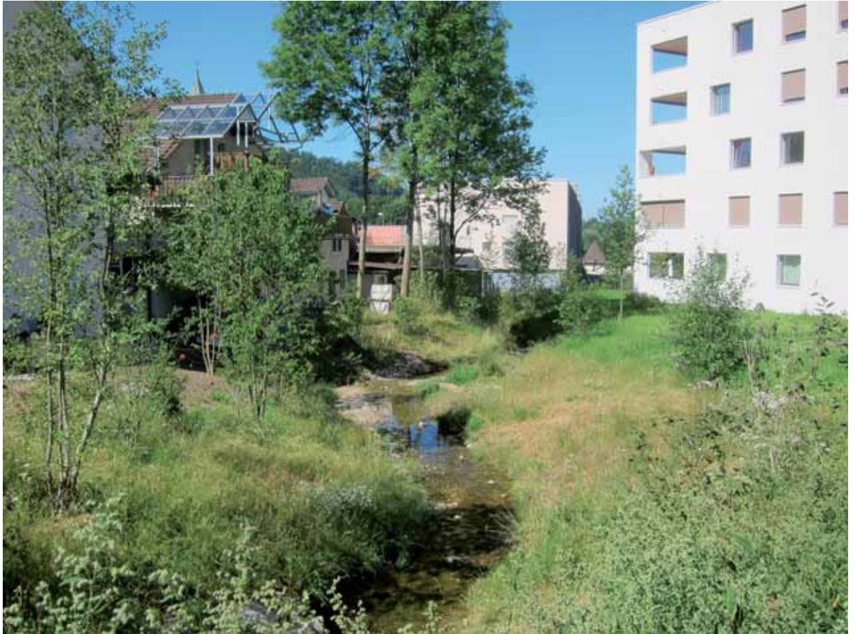
Im Rahmen eines privaten Gestaltungsplanes konnte der Schlipfbach in der Gemeinde Wald 2012 im Bereich Rütli- bis Jonastrasse (Claridapark) hochwassersicher und naturnah ausgebaut werden. Quelle: AWEL
