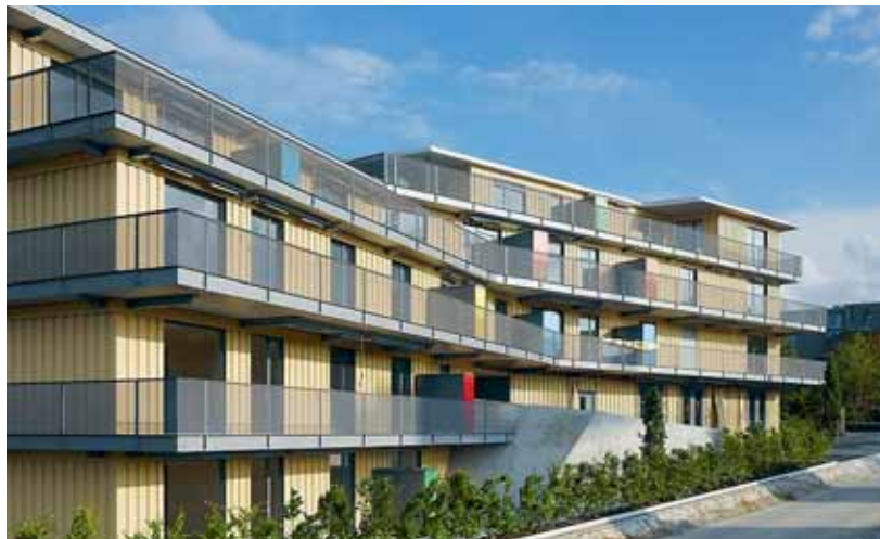
Die Siedlung Wolfswinkel in Zürich-Affoltern umfasst 189 Wohnungen mit 2 1/2 bis 5 1/2 Zimmern. Jede Wohnung ist mit einem individuellen Lüftungsgerät ausgerüstet. Quelle: Hannes Henz
