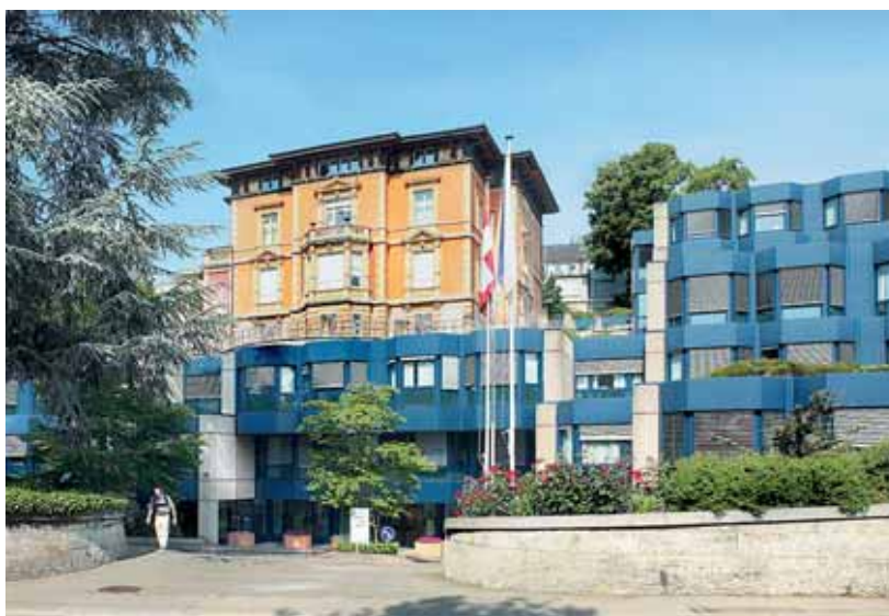
Die Klinik im Park hat dank Beratung neue Wege bei der Parkplatzbewirtschaftung beschritten.
