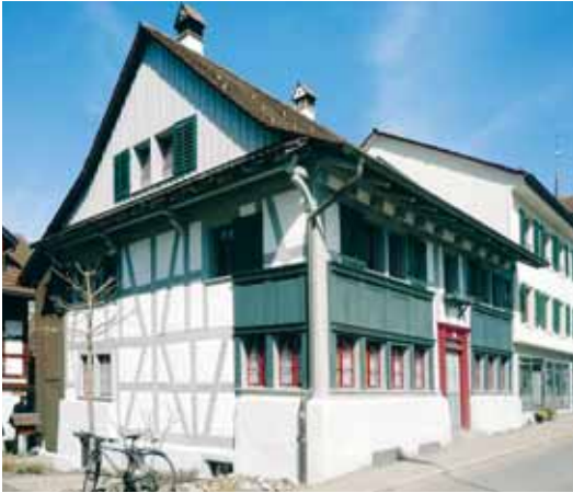
Die Problematik bei der Lärmsanierung dieses Flarzhauses ist komplex: Die Doppelverglasung aus den 1980er Jahren ist in denkmalpflegerischer Hinsicht von untergeordneter Bedeutung und könnte ersetzt werden. Die über einen Seilzug zu bedienenden Falläden hingegen sind wichtige historische Bauzeugen und damit zu erhalten. Schallschutztechnisch problematisch sind hier die Schallbrücken bei den Durchdringungen des Seilzugs. Quelle: TBA
