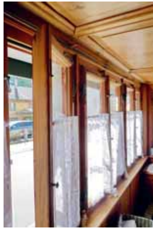
Die Problematik bei der Lärmsanierung dieses Flarzhauses ist komplex: Die Doppelverglasung aus den 1980er Jahren ist in denkmalpflegerischer Hinsicht von untergeordneter Bedeutung und könnte ersetzt werden. Die über einen Seilzug zu bedienenden Falläden hingegen sind wichtige historische Bauzeugen und damit zu erhalten. Schallschutztechnisch problematisch sind hier die Schallbrücken bei den Durchdringungen des Seilzugs. Quelle: TBA
