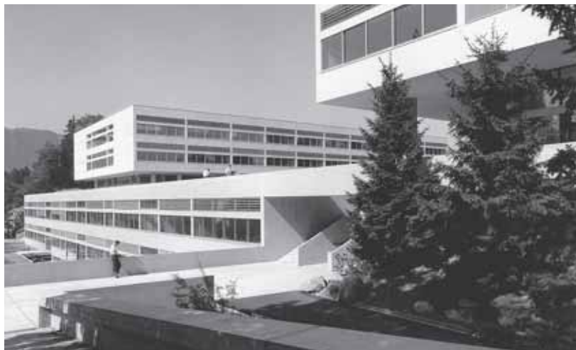
Die Kantonsschule Freudenberg, Zürich (1955), ist eines der modernen Baudenkmäler im Kanton. Quelle: HBA
