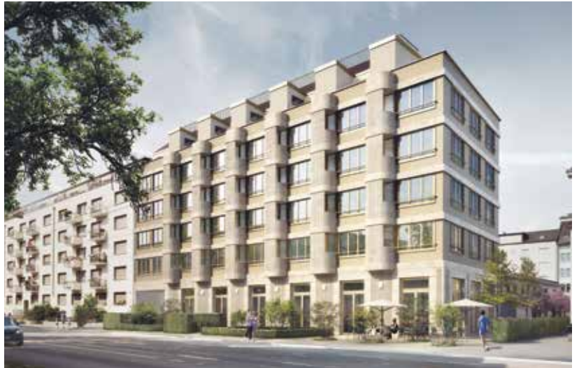
Ein vom Kanton gefördertes Pilotprojekt mit der Hochleistungswärmedämmung Aerogel an der Hohlstrasse in Zürich. Quelle aller Abbildungen: AWEL
