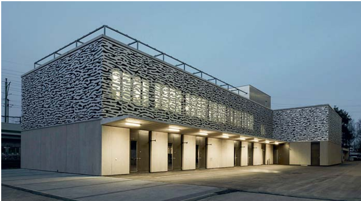
Die vorgehängte Fassade aus Aluminiumblech dient auch als fixer Sonnenschutz: Neubau Eawag-Forschungsgebäude Aquatikum in Dübendorf. Quelle: Andreas Müller Architekten AG, Patrik Fuchs
