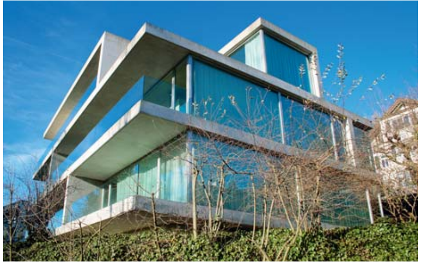
Wohnbauten mit so grossen Glasfronten saugen Sonnenlicht regelrecht ein – ein Problem im Sommer? Quelle: trevor.patt, flickr (CC BY-NC-SA 2.0)
