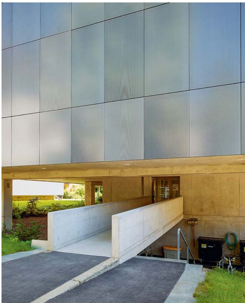
Von nahem wirkt die Fassade fast futuristisch, die Solarmodule werden Teil des Designs. Quelle: Andrea Helbing, Arazebra, Atelier für Fotografie, Zürich
