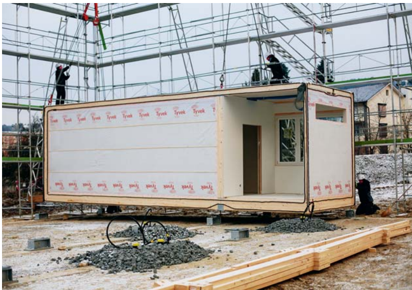
Die Standardmodule wurden vorgefertigt und vor Ort innert weniger Tage auf- und ausgebaut. Quelle: HBA
