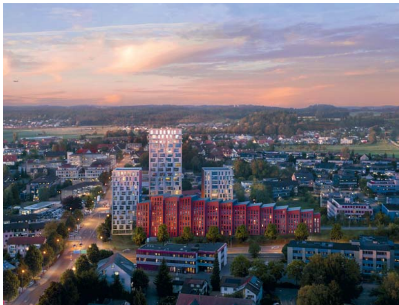
Das Brütiseller Tor – Visualisierung des Siegerprojekts für eine verdichtete Zentrumsüberbauung. Quelle aller Abbildungen: Rimaplan AG
