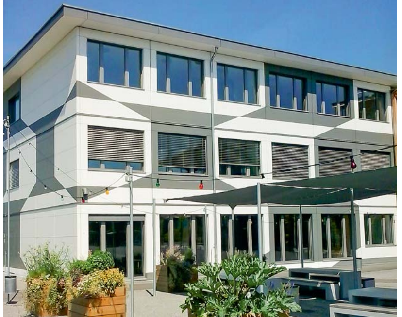
Die provisorische Kanti Uetikon ist nachhaltig, flexibel sowie ästhetisch. Quelle: Erudin, Wikimedia Commons, CC BY-SA 4.0
